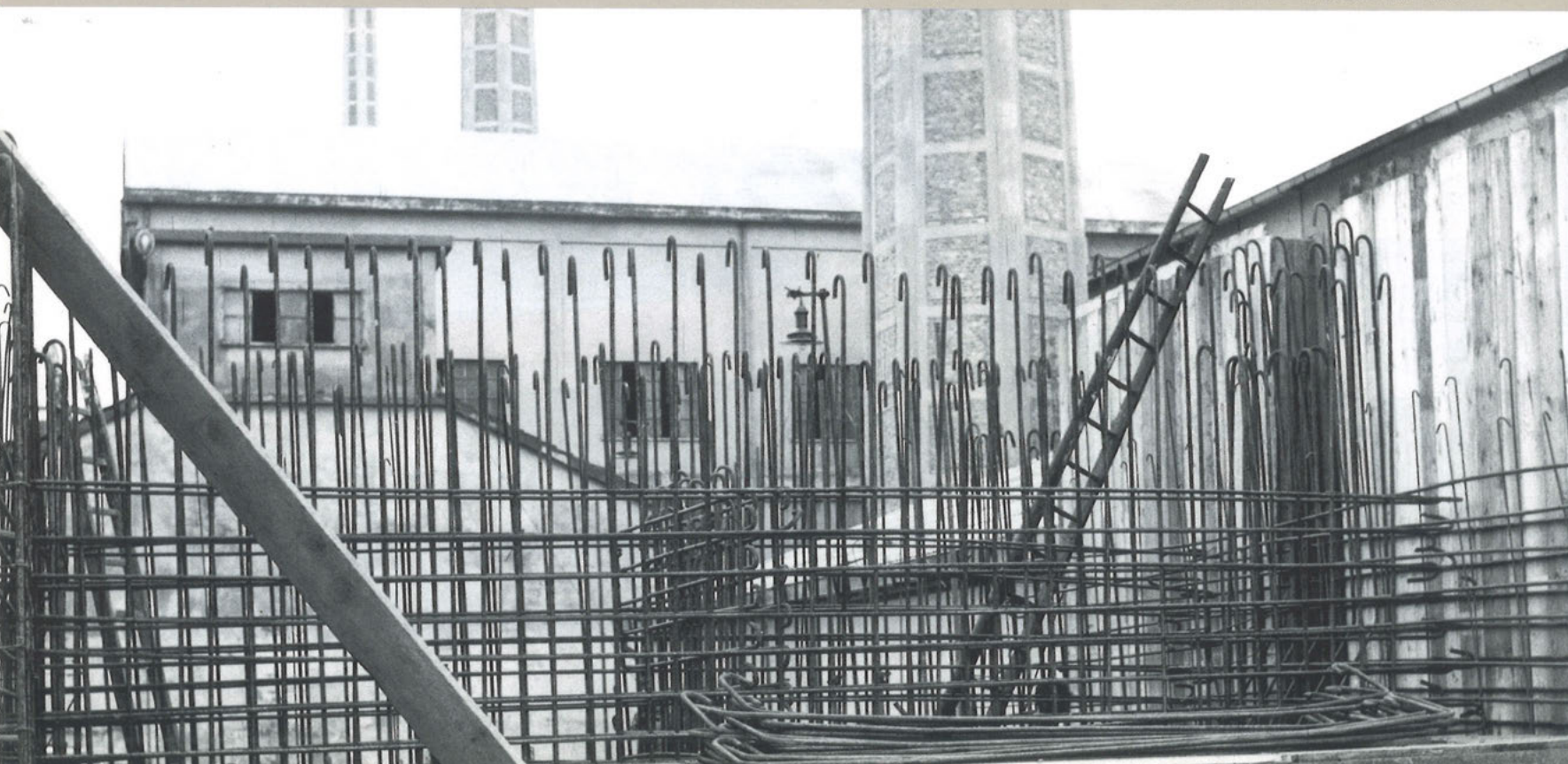
▼ OPERA SILOS E DEPOSITI PER LA VETRERIA MILANESE A CORSICO (MILANO) • ANNO 1961-1963 • STRUTTURISTA ABELARDO E ANGELO FERRARESI
